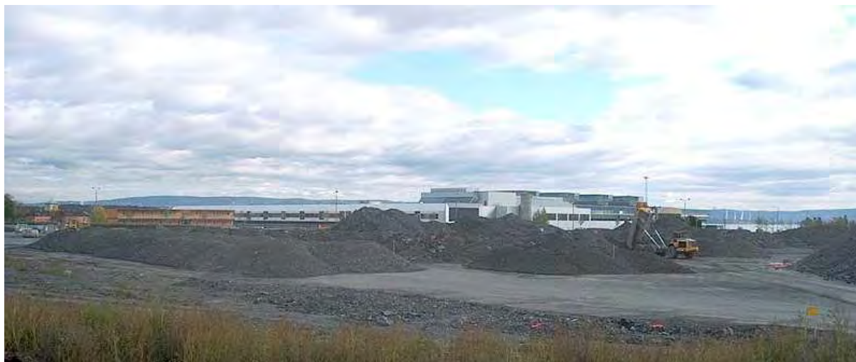
Figur 27. Fylkesmannen er ofte betydelig involvert i planlegging av større utbygginger. Bildet viser arbeider med utbygging på Fornebu. Foto: Miljødirektoratet
