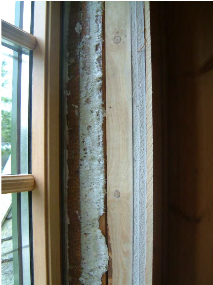
Figur 20. Ekstra lydisolering av eldre hus er ofte nødvendig for å tilfredsstillere krav til innendørs lydnivå ved nye vegprosjekter. Her et eksempel med nye vinduer og bruk av doble gipsplater innenfor panel. Foto: Statens vegvesen
