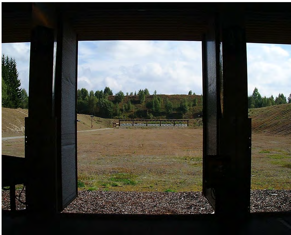
Figur 61. Eksempel på en bane med omfattende støytiltak: Overbygd standplass med frambygge, absorbentkledte båsvegger og høye støyvoller. Bildet er fra Bane 17 på Sessvollmoen. Foto: Forsvarsbygg
