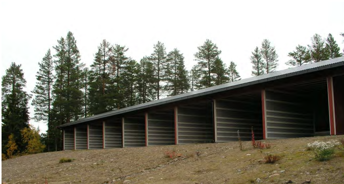
Figur 59. Nytt støydempet standplassoverbygg, Nybergsund skytebane. Foto: DFS
