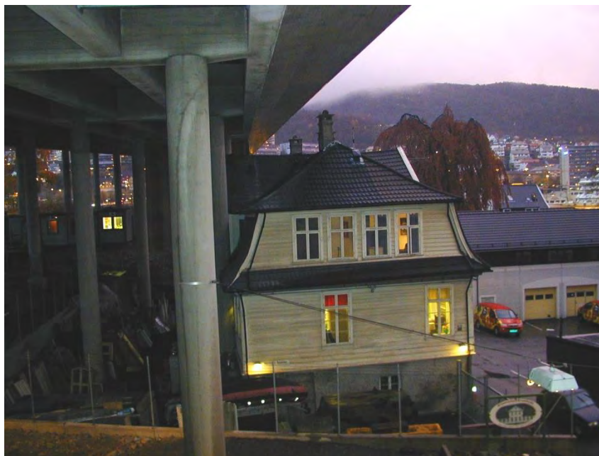
Figur 31. Ofte må noen hus innløses ved større veganlegg. Foto: Miljødirektoratet
