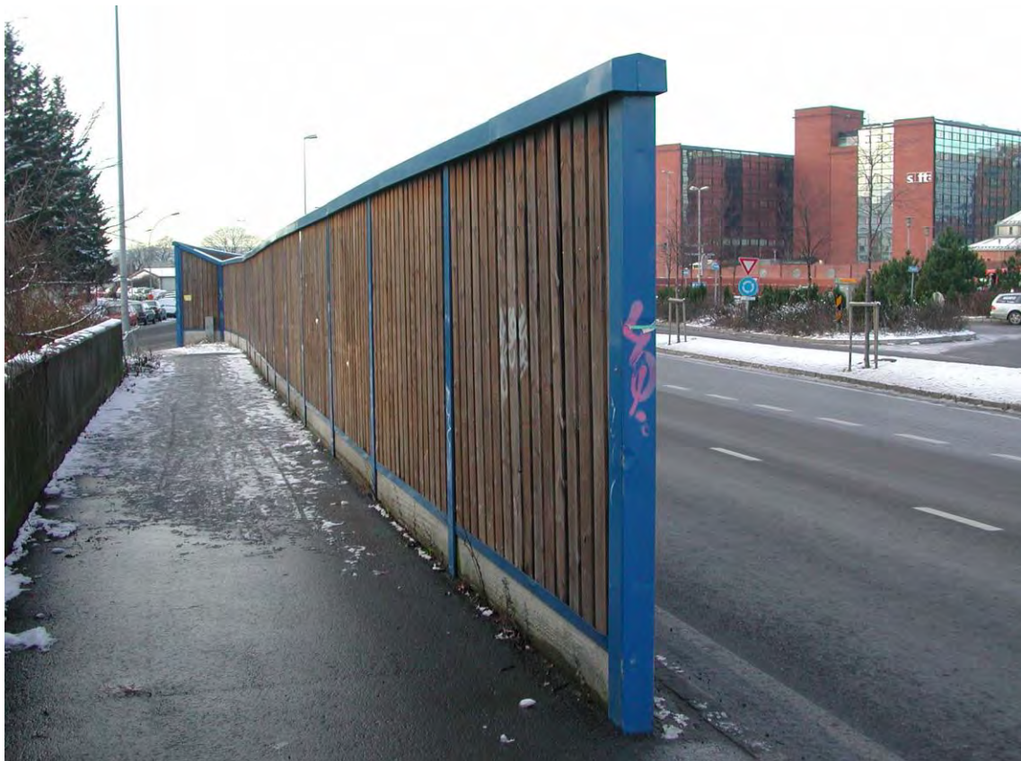
Figur 13. Støyskjerm – et mye benyttet tiltak – som må vedlikeholdes. Foto: Miljødirektoratet
